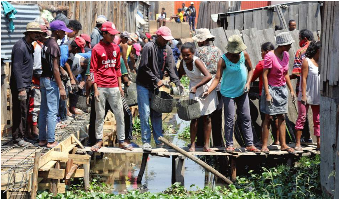
Photo 2 : Mobilisation des habitants pendant les travaux.
