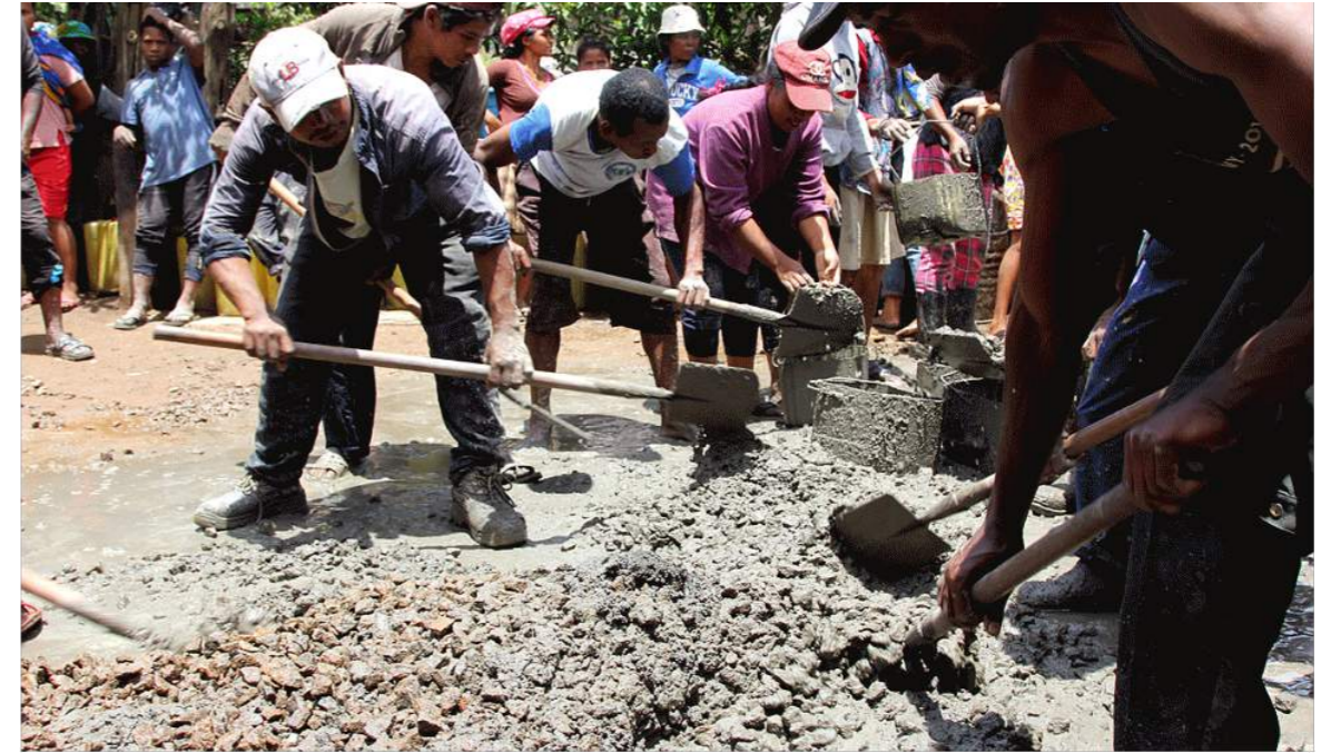
Photo 3 : Travaux en cours.
