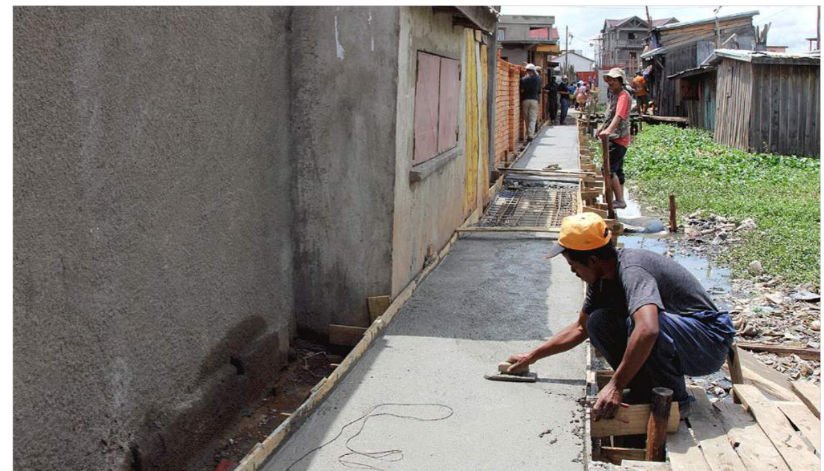
Photo 4 : Une partie des passerelles en cours de finition.
