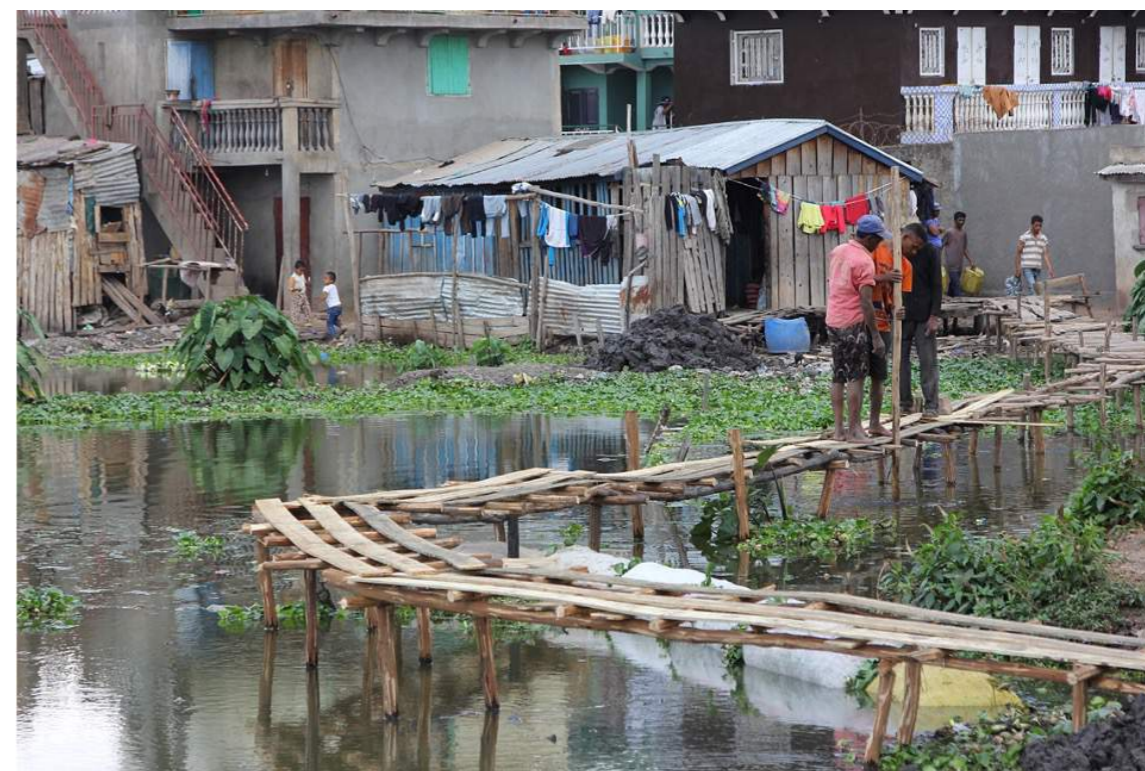
Photo 1 : Etat des passerelles en bois avant les travaux.
