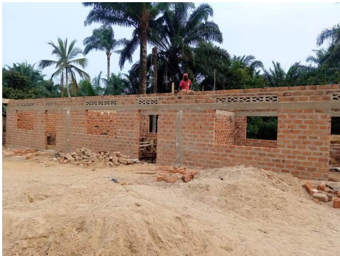
Photo 1 : Travaux de construction des salles de classes
