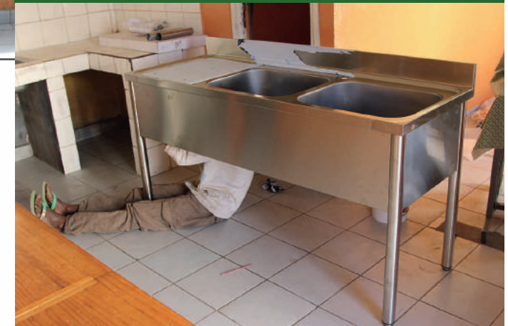
La nouvelle cuisine en cours d'aménagement
